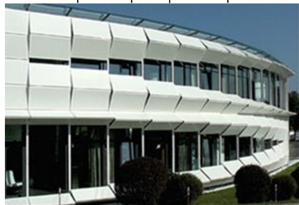
Рис. 4. Сонцезахисна регульована фасадна система на офісній будівлі Kiefer Technic Architecture Showroom, розроблена студією Ernst Giselsbrecht + Partner, Австрія
