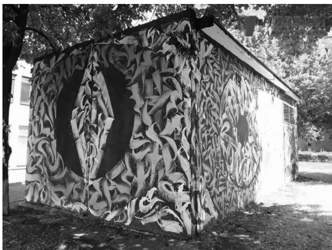
Рис. 14. Трансформаторна підстанція розписана Олександром Зінов'єм [17]
