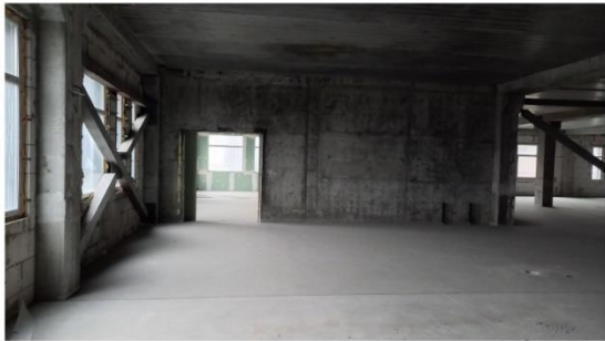
Рис. 3-4 Існуючий вигляд приміщення
