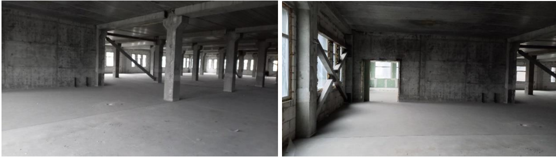
Рис. 2.3. Існуючий вигляд приміщення.
