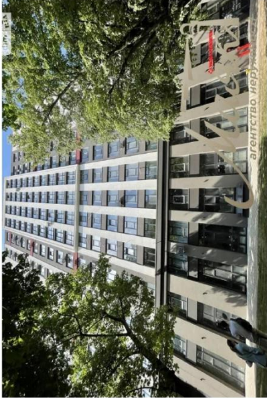
Рис. 3 Фасадна частина об'єкту
