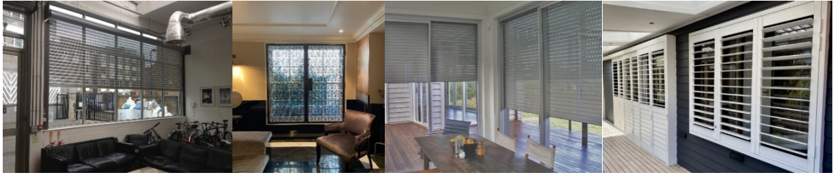
Рис. 7. Фото захисту вікон (загородження, ролети, жалюзі із металу)
