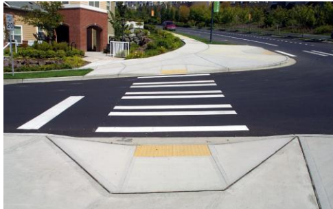
Рис. 2. Пандус і понижений бордюр на тротуарі біля проїжджої частини: елемент безбар'єрної інфраструктури, що забезпечує доступність на перехрестях та зупинках громадського транспорту для маломобільних груп населення.
