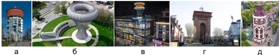
Рис. 1 Приклади світового та вітчизняного досвіду ревіталізації водонапірних веж: а - Jægersborg Water Tower, Данія; б - Park Nauki Torus, Польща; в - Бібліотека «Водонапірна вежа», Китай; г - Jumbo, Велика Британія; д - Vezha Creative Space, Маріуполь, Україна.
